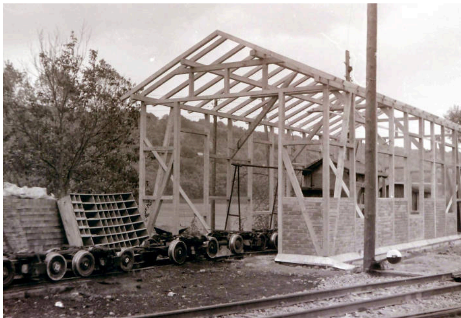
▲ Im Frühjahr 1970 war in Möckmühl der Bauvortschritt des ab Herbst 1969 in ehrenamtlicher Arbeit begonnenen Wiederaufbaus der Lokstation für den bevorstehenden Museumsverkehr gut zu erkennen. / Gerald Gunzenhäuser
