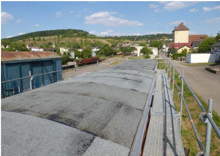
Die aufgeschweißte Dachpappe an beiden Wagen / Bild Hartmut Schirmmacher
