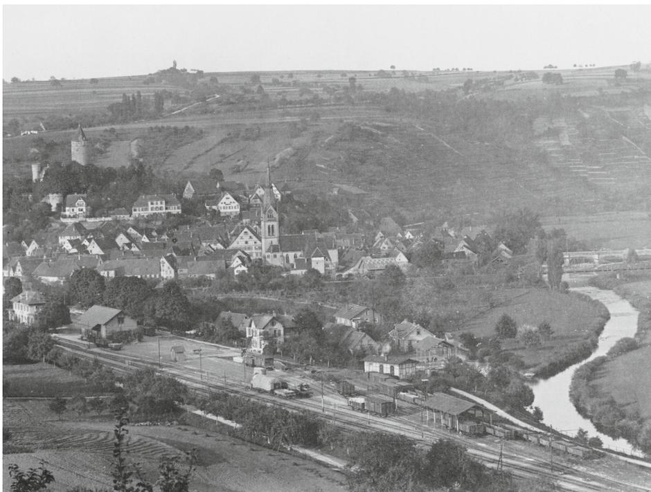
Die Ansicht auf Möckmühl von Süden im September 1916 gewährt einen eindrucksvollen Überblick über die Schmalspurgleisanlagen der Jagsttalbahn mit Umladeschuppen, Lokschuppen und Rollschemelgrube. Am rechten Bildrand erkennt man die Bogenbrücke über die Jagst. (Foto: Gebrüder Metz 63388, Slg. Haus der Geschichte Baden-Württemberg)
