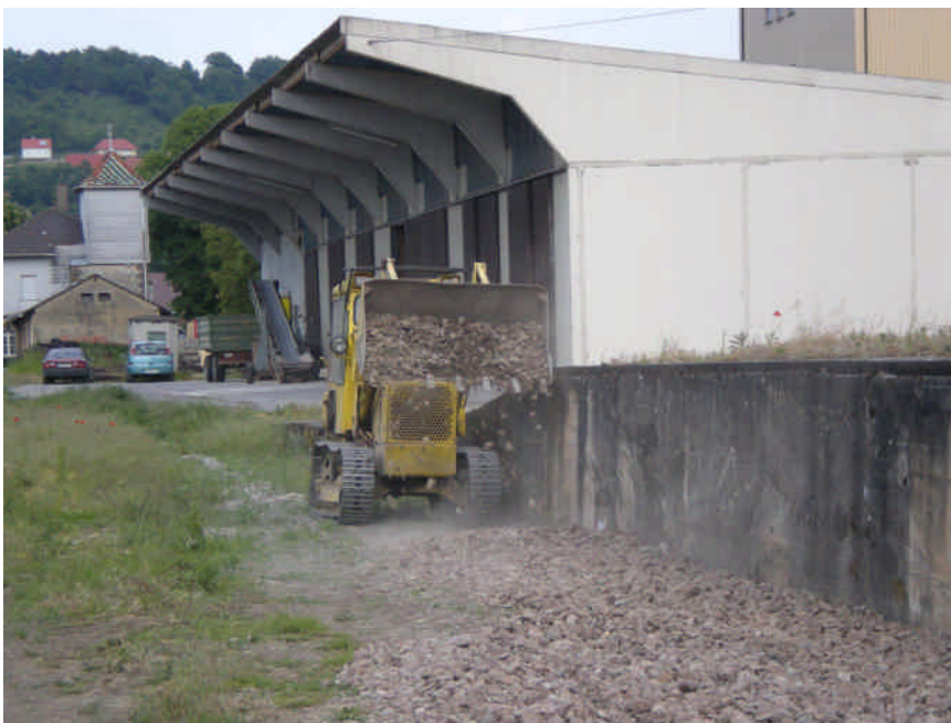
Die Schotterschicht für Gleis 4 entsteht (Bild: Stefan Haag)
