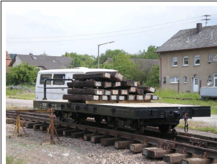
Wagen 754 mit Schwellen beladen auf der Gleisbaustelle (Bild: Stefan Haag)
