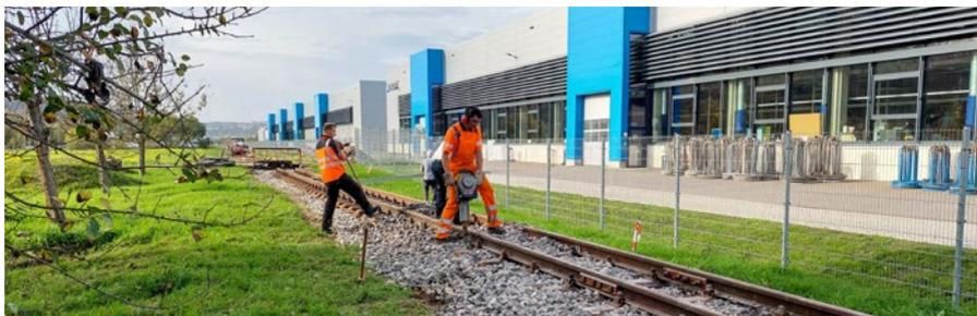
Wochen konnten weitere 60 Meter aufgebaut werden. In diesem Bereich wurde auch erstmals das Abladen von Schienen vom Flachwagen 435 ohne Radlader geübt. Das Schienenprofil wird an einem Fixpunkt befestigt und der Wagen fährt zurück. Über ein Art Rutsche, die in den Flachwagen eingehängt wird, wird das Schienenprofil nach unten geführt.
