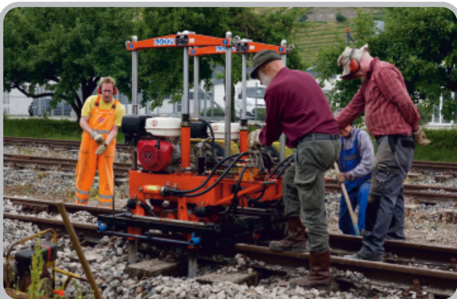
oben: Stopfen von Gleis 1, zwei Mann bedienen die Stopfmaschine, zwei bauen Winden ein und aus und ziehen den Schotter glatt rechte Seite: Ablauf beim Richten des Gleises mit Winden (Bilder: Stefan Haag)
