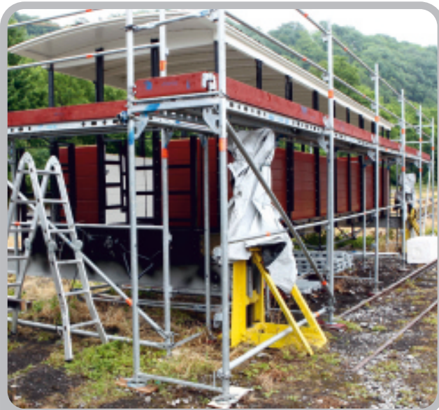
links oben: das Dach wird neu eingedeckt (Bild: Volker Elgner) links unten: einiges Holz musste ersetzt werden (Bild: Stefan Haag) oben: die neuen Seitenwände (Bild: Rolf Wilkes)
