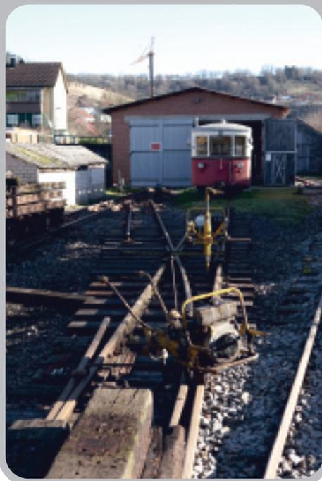
nem neuen Trageisen montiert. In den folgenden Tagen ging es mit dem Schwellentausch weiter, außerdem wurde die Verbindung zwischen Gleis 1 und Gleis 2 eingeschottert, angehoben und gestopft.
