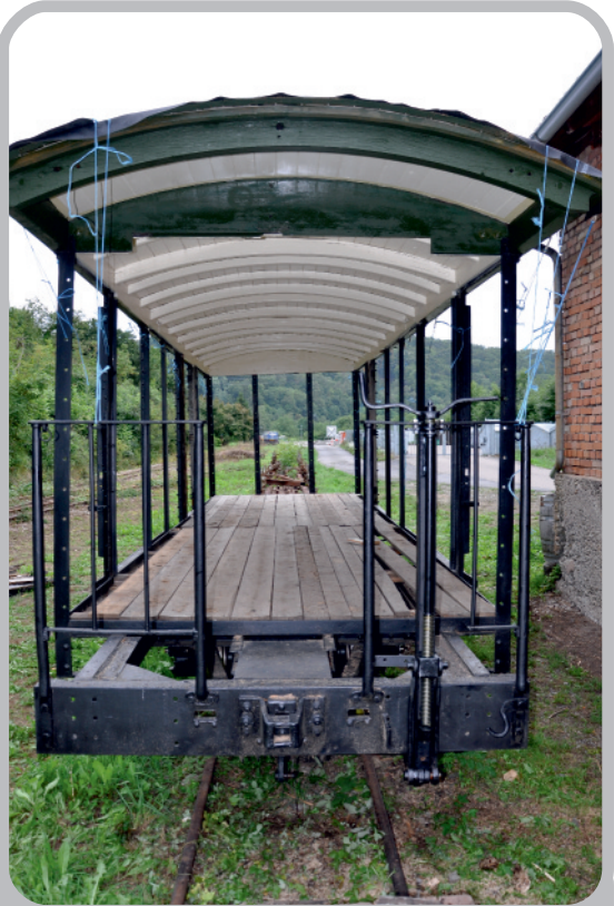
Der derzeitige Arbeitsstand am Wagen Nr. 89. Der Boden ist natürlich nur provisorisch. (Bild: Frieder Strohm)
