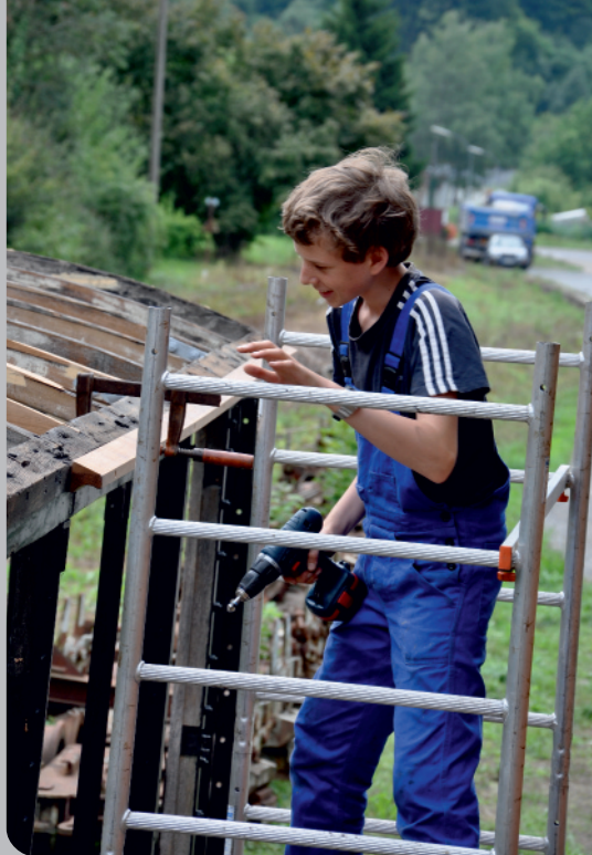
Martin Strohm auf dem Gerüst (oben) bei der Montage der Leisten, die später den Dachüberstand bilden und einer der ersetzten Dachbögen (zweiter von vorne, unteres Bild). (Bilder: Frieder Strohm)
