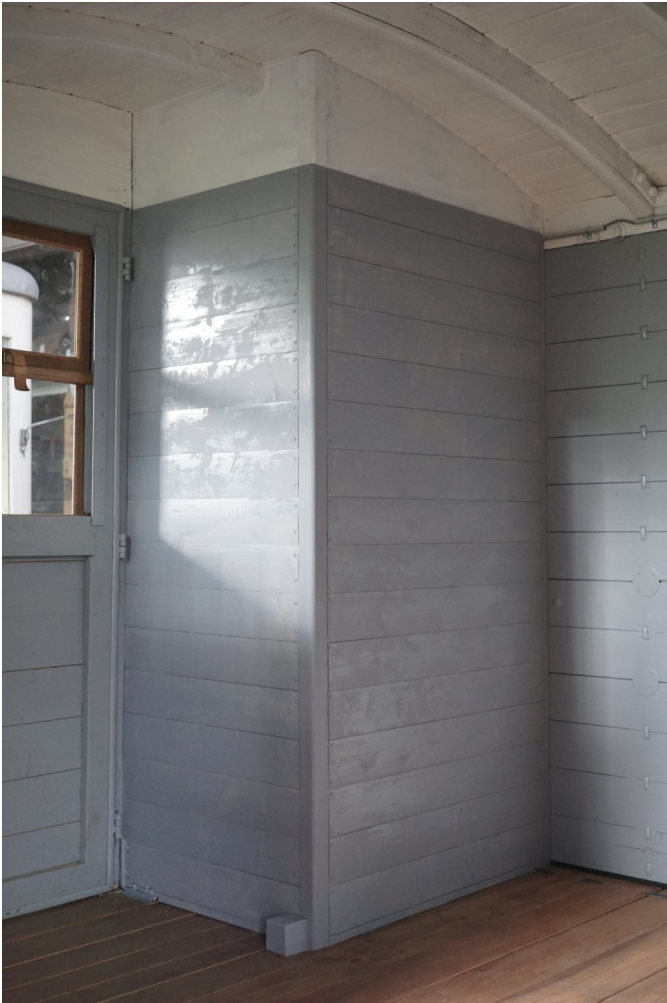
Abbildung 6: Trennwand zwischen dem Gepäckabteil und den ehemaligen Abort. Bild: Stefan Haag
