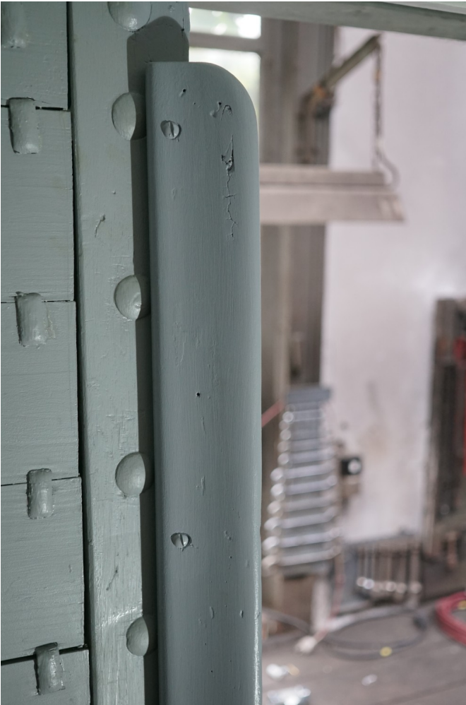
Abbildung 5: Am 1.10.2022 wurden die originalen Fingerklemmschutzleisten eingebaut. Bild: Stefan Haag
