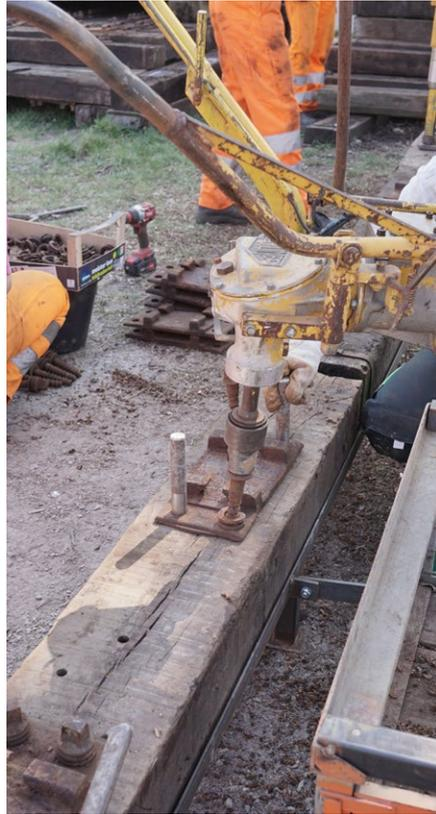
Bilder: Die Rippenplatten werden auf die Schwellen geschraubt.
